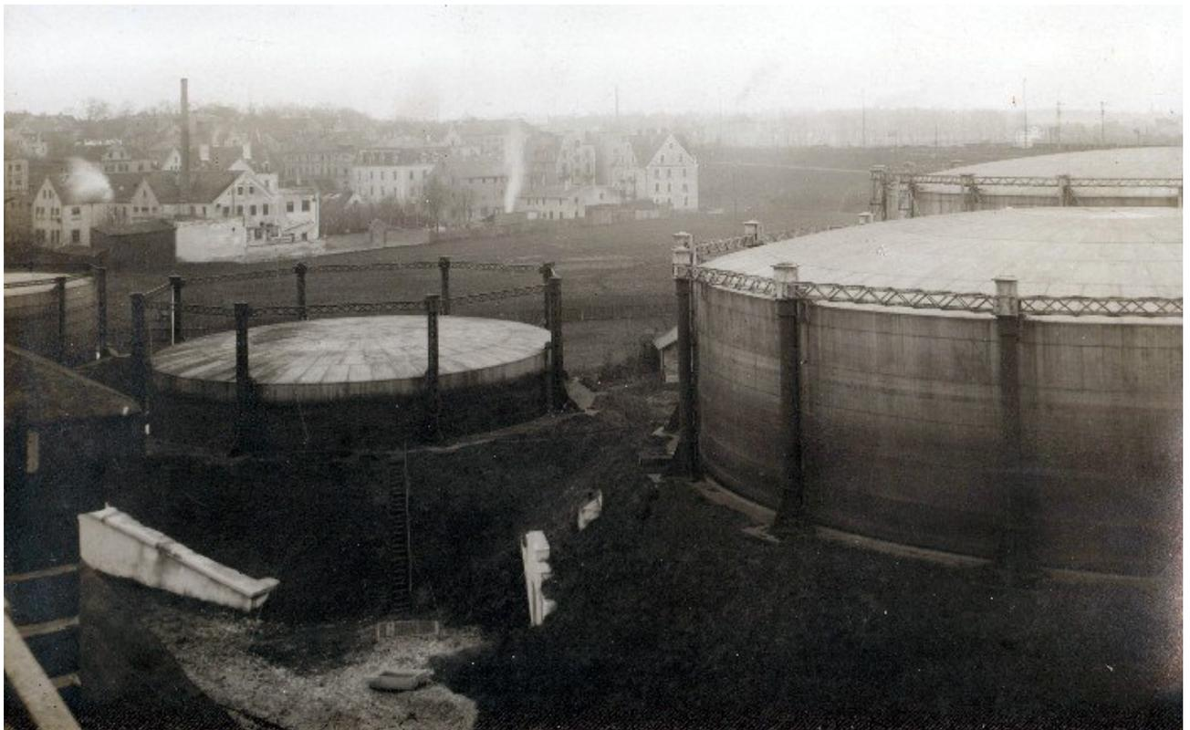
Foto 1: Vier Glocken-Gasbehälter am Gaswerk Badstraße in Augsburg [U1]
