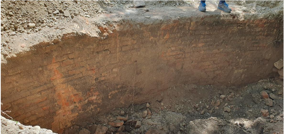
Foto 2: Ringmauer Innenansicht des Gaskessels
