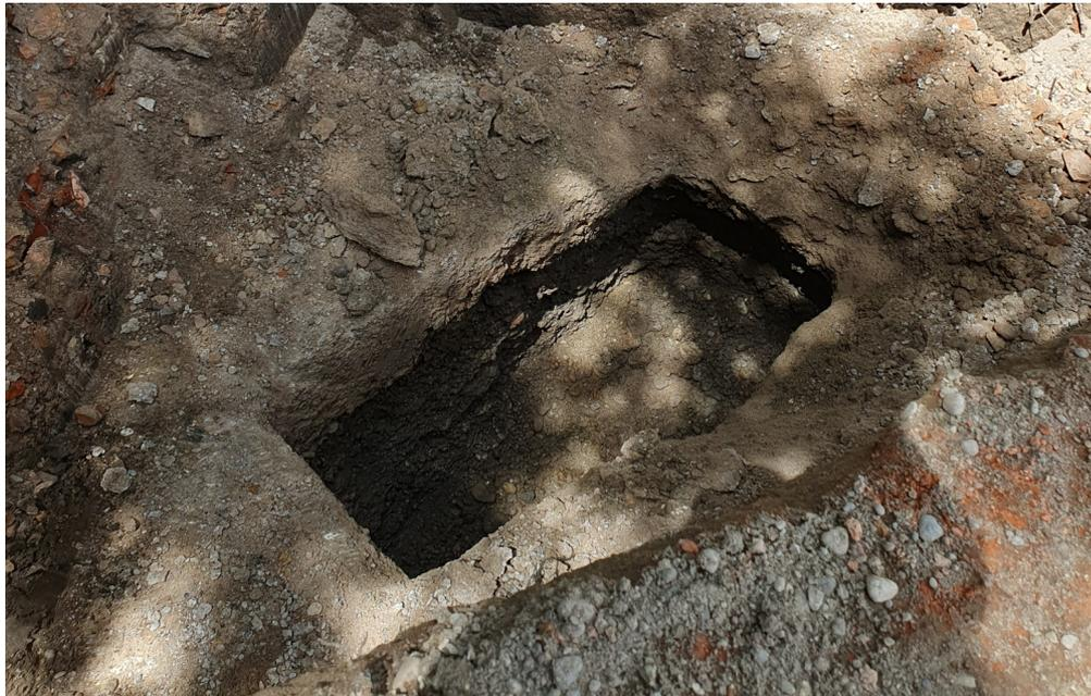
Foto 5: Schurf durch Stampfbeton des Gaskessels
