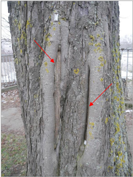
Abb. 14 Borkenschäden Stamm Nordseite
