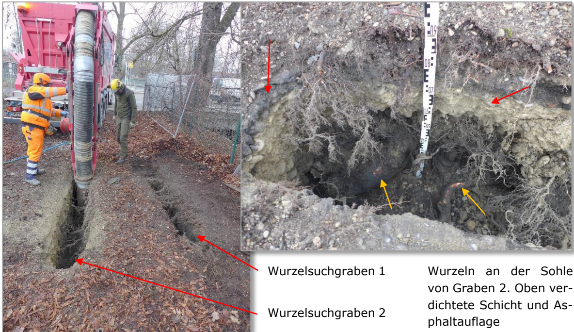
Abb. 18 Wurzelsuchgraben Nr. 2 (Pos. 1)
