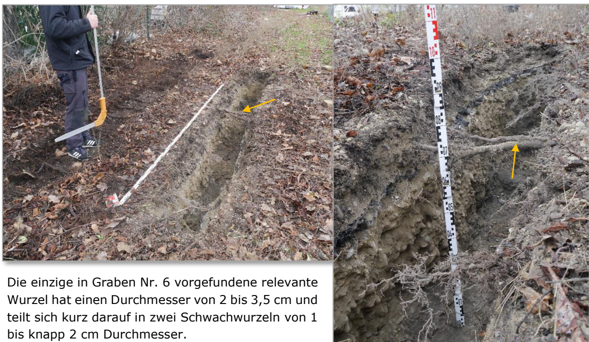
Abb. 24 Wurzelsuchgraben Nr. 6 (Pos. 3)
