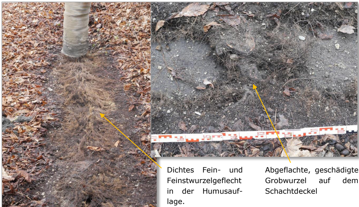
Abb. 20 Wurzelsuchgraben Nr. 3 (Pos. 2)
