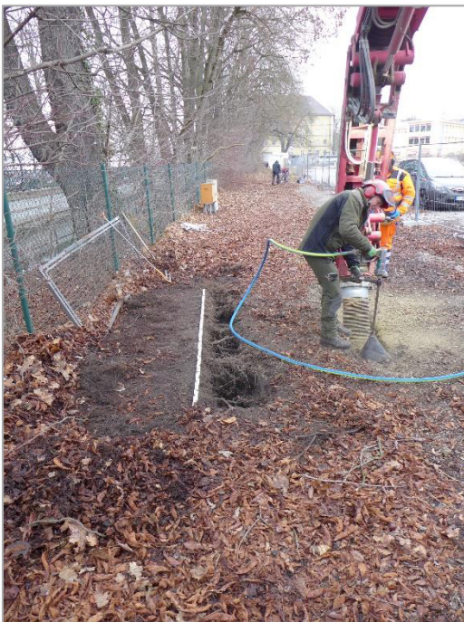
Anlage des zweiten Suchgrabens mithilfe von Druckluftdüse und Saugbagger rechts von Graben Nr. 1
