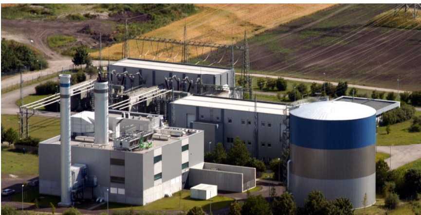
Modernisierung der Kraft-Wärme-Kopplung durch den Bau der Gasturbinenanlage GT-Ost (Erdgas)
