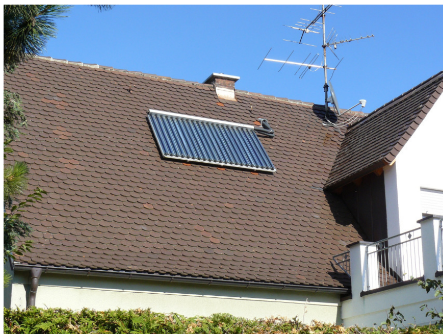
Röhrenkollektoranlage in Augsburg-Haunstetten
