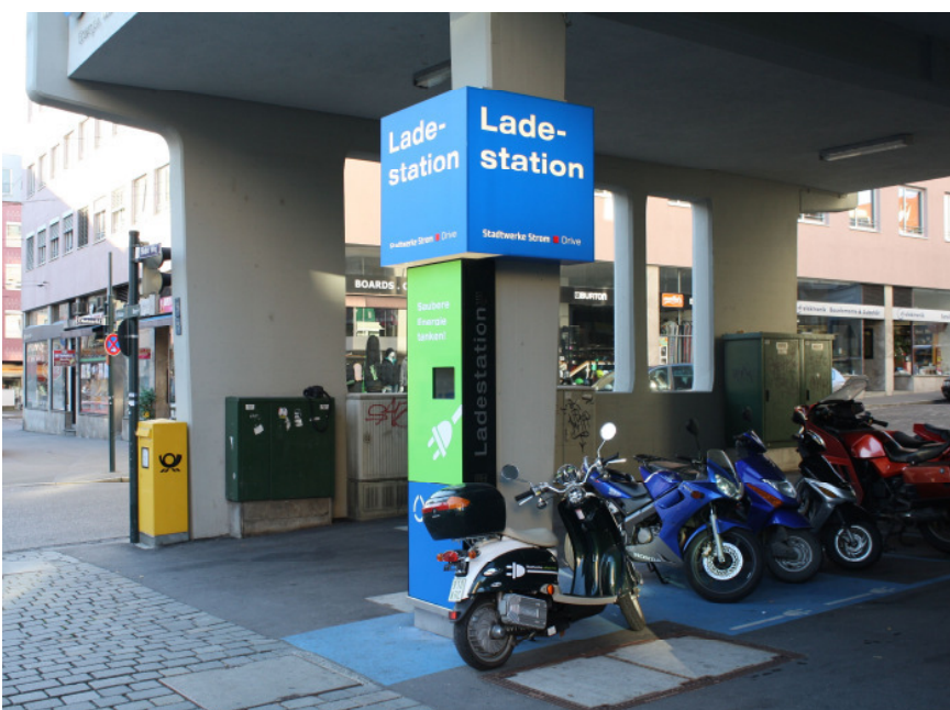
Erste Stromtankstelle der Stadtwerke Augsburg: Standort: Hoher Weg 1, 86152 Augsburg
