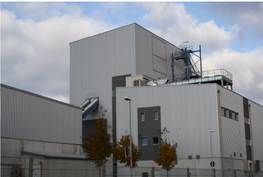
Im Biomasse-Heizkraftwerk der Stadtwerke Augsburg werden seit 2008 alljährlich rund 80.000 Tonnen Hackschnitzel verfeuert und damit Strom und Wärme produziert.
