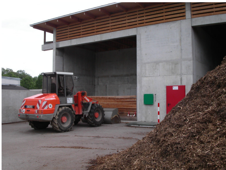
Brennstofflagerung der Holzhackschnitzelanlage im Botanischen Garten
