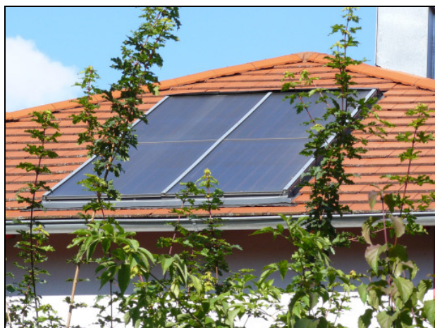
Flachkollektoranlage in Augsburg-Haunstetten
