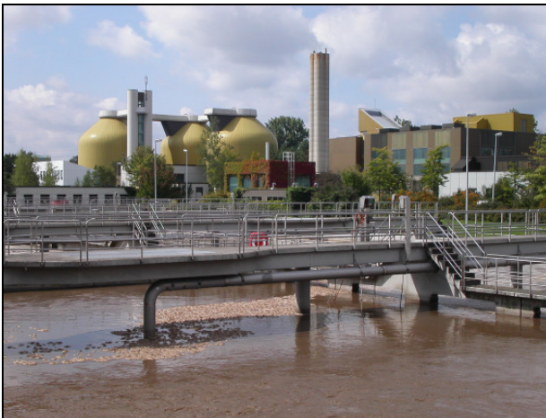
Im Klärwerk Augsburg wurden über die Blockheizkraftwerke (Klärgas) rund 11,5 Mio. kWh in das Netz eingespeist.
