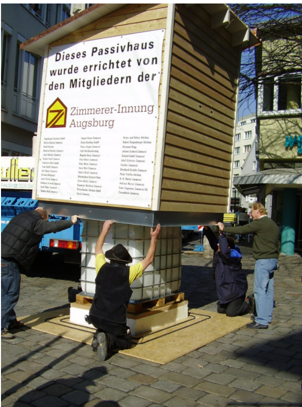
Aufbau des Passivhauses am Rande des Rathausplatzes
