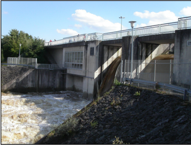
Die Wasserkraftanlage „BEW Wertachstausee“ erzeugte 11,1 Mio. kWh in 2006.
