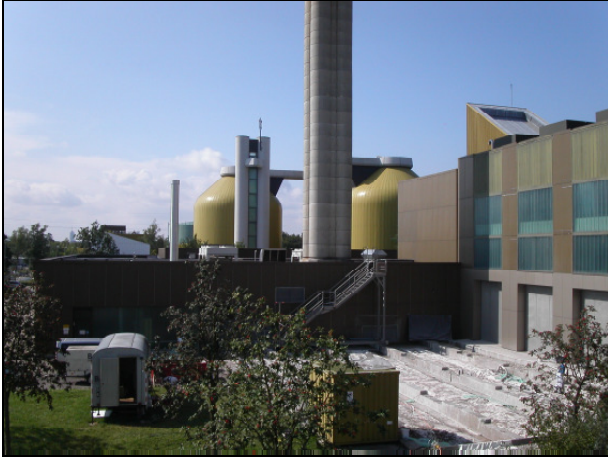
Seit dem Jahr 2003 nach DIN ISO 14001 zertifiziert: Klärwerk Augsburg
