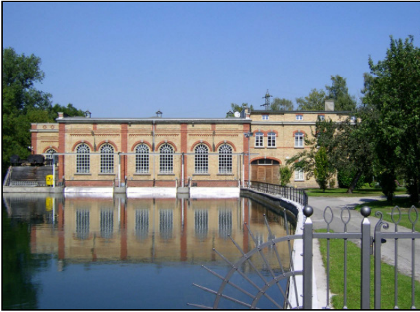
Kraftwerk Winter (TW 81, vereinigter Stadt- und Proviantbach)
