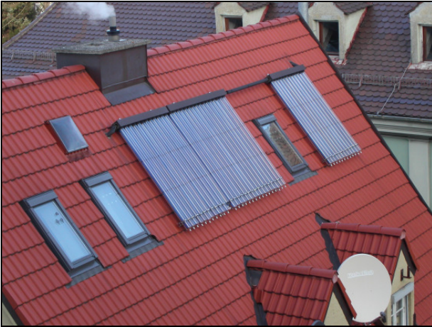
Röhrenkollektoranlage zur Warmwasserbereitung auf einem Hausdach in der Augsburger Innenstadt
