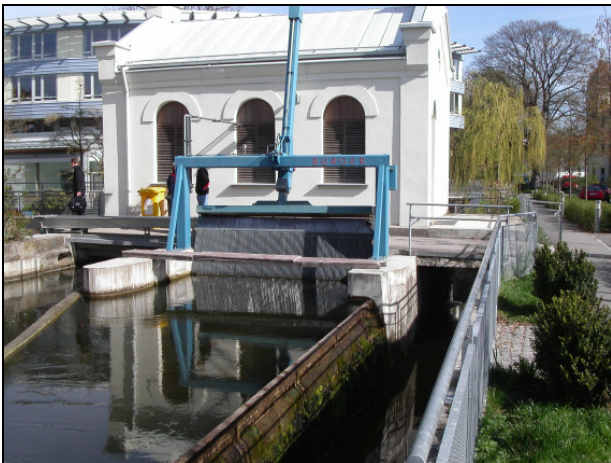
Hessing-Wasserkraftanlage (TW 96, Singold)
