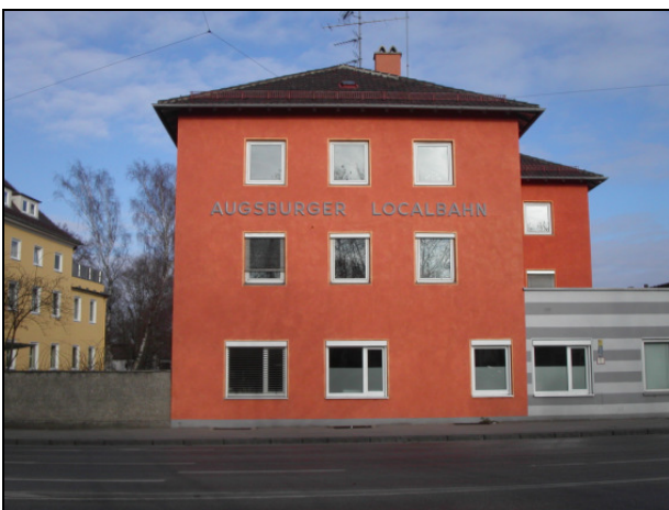
Betriebsgebäude der Augsburger Localbahn
