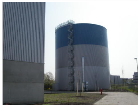
... und auf den Heißwasser-Speicher
