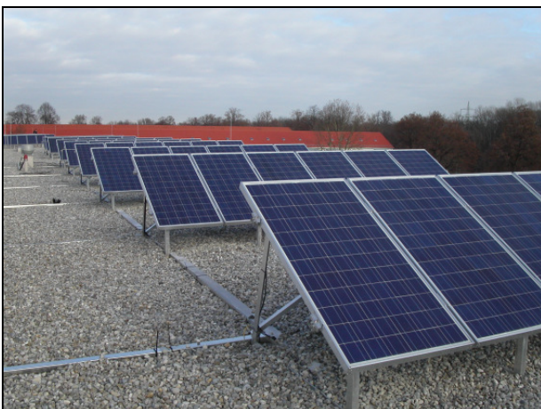
PV-Module auf dem Unterrichtsgebäude der Drei-Auen-Grundschule
