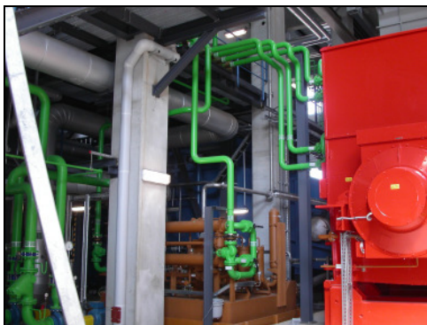
Blick in das Innere des Heizkraftwerkes
