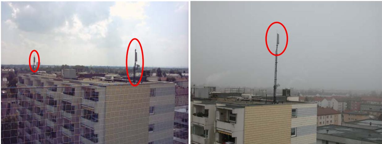
**Bild 7:** Anlagenstandort von Messpunkt 7a aus gesehen (links: 2002, rechts: 2004). Deutlich ist die Erhöhung des nördlichen Antennenträgers zu erkennen.
