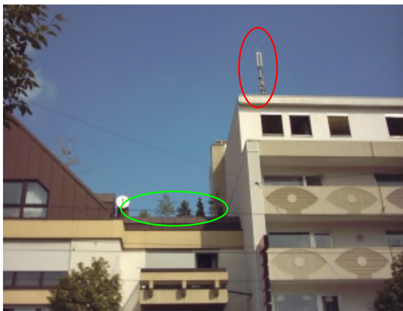
Bild 7: Messpunkt 8 (Benachbarte UMTS-Antenne noch nicht in Betrieb)
