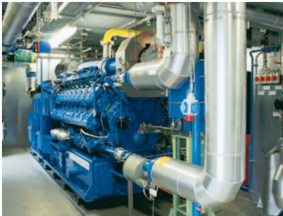
Blockheizkraftwerk (BHKW)
