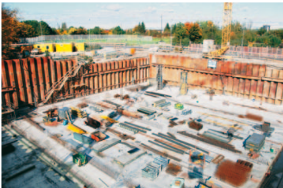
Bau eines Regenbeckens
