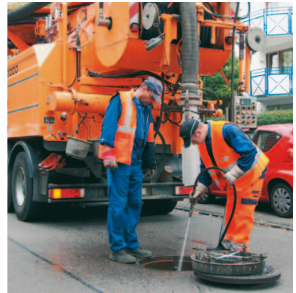
Ein Kanalspülwagen im Einsatz
