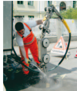
Inspektionsarbeiten mit Kanalkamera
