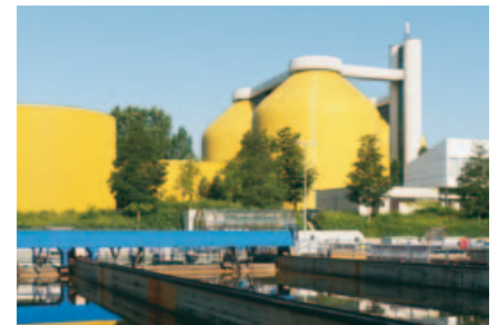
Vorklämung mit Faulbehälter
