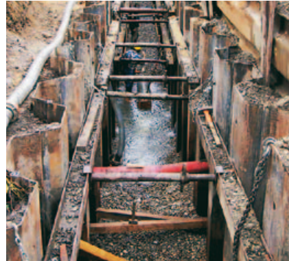
Kanalbau und -begehung (rechts)
