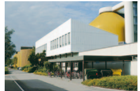
Betriebsgebäude mit Schaltzentrale
