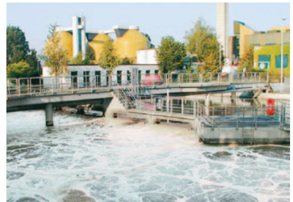
Belebungsbecken – auf der Wasseroberfläche sind die aufsteigenden Luftblasen zu erkennen.
