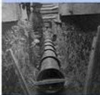
Verlegung eines Steinzeugrohrkanals 1910
