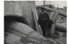
Baustufen Wertachdüker 1910/11: Mauerung der Trompeteneinmündungen an den Schiebern des Zuflussbauwerks
