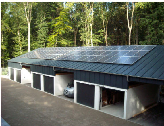
Photovoltaikanlage auf dem Carport
