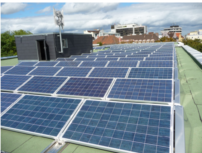
Photovoltaikanlage auf dem Dach
