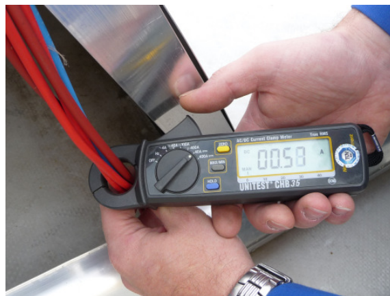
Messung bei der Abnahmeprüfung
