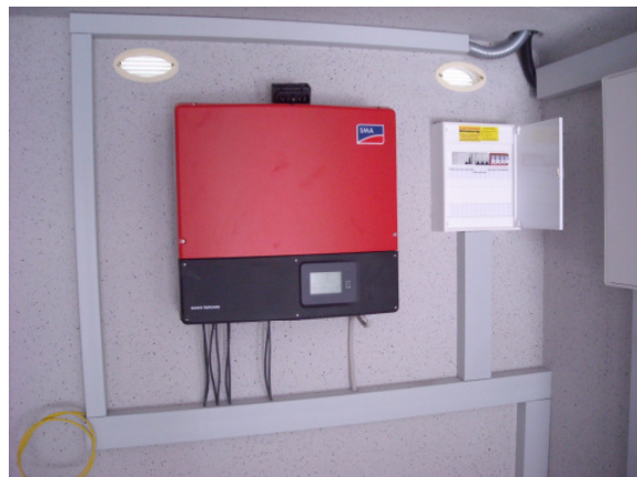
Wechselrichter
