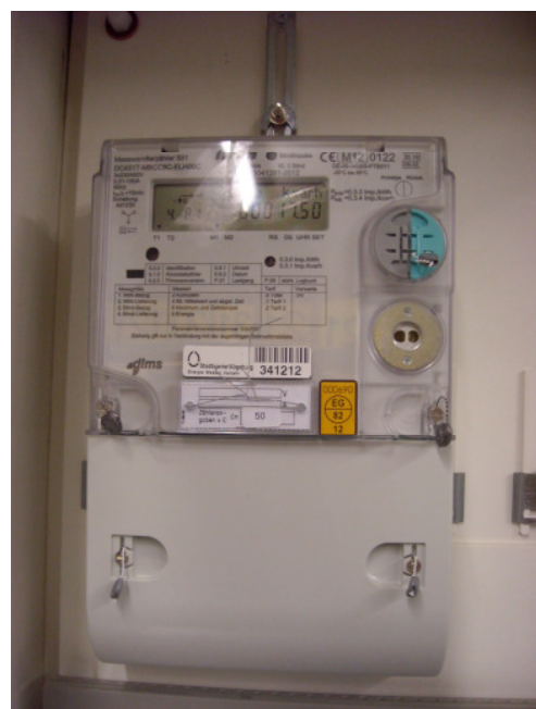
Stromzähler für Einspeisung in das Netz
