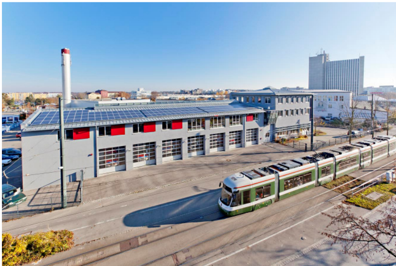
PV-Anlage auf der Feuerwache-Süd
