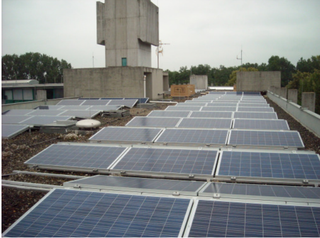
PV-Anlage auf der Hauptfeuerwache
