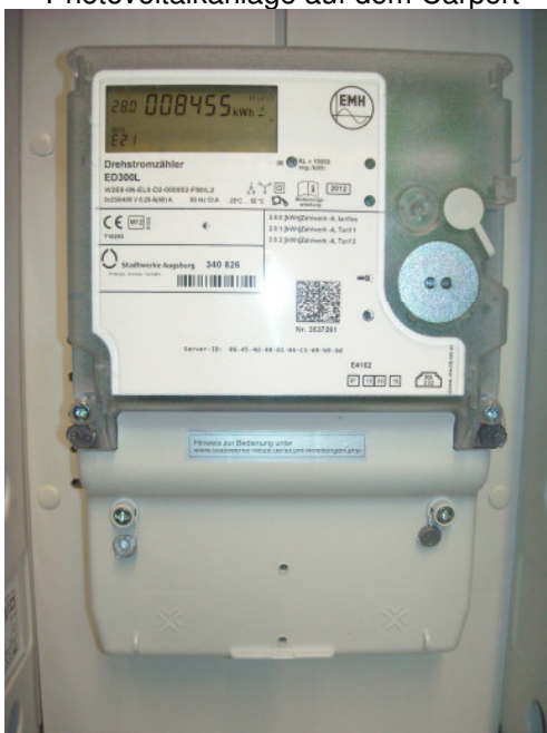
Stromzähler für den Gesamtstrom
