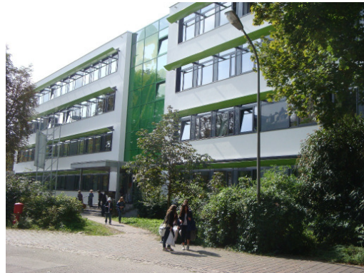
Bertolt-Brecht Schule nach Sanierung
