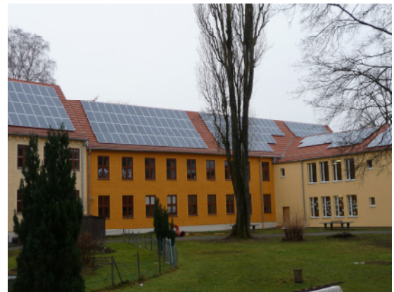
Bärenkellerschule (Anlage fertig gestellt)
