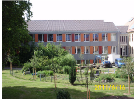
Nach der energetischen Sanierung
