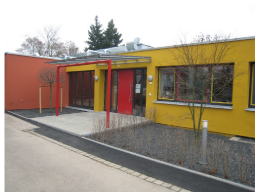
Kindergarten Pumuckl nach Sanierung
