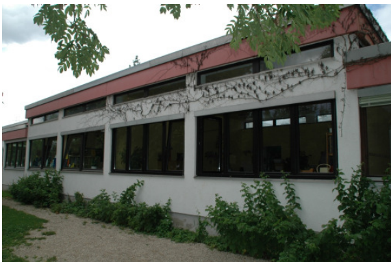
Kindergarten Pumuckl vor Sanierung
