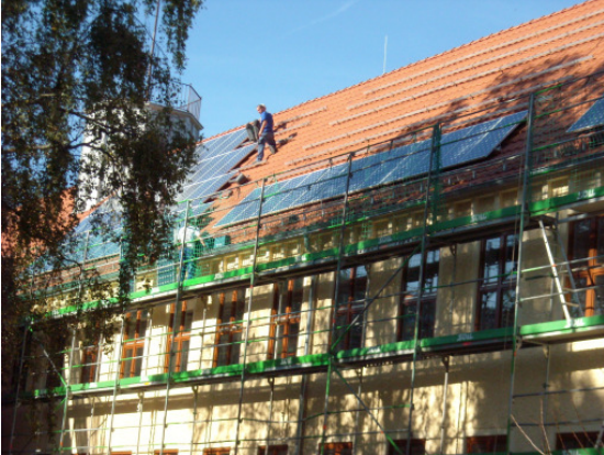
Bärenkellerschule (Anlage im Bau)
