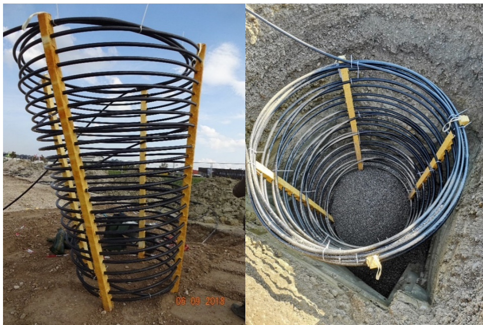
Abbildung 22: Erdwärmekörbe zu Erschließung der Erdwärme
