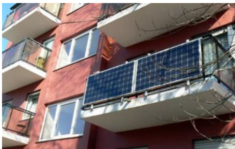
Abbildung 46: Balkonkraftwerk
