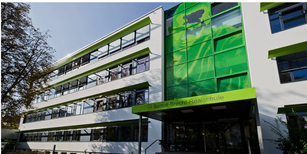
Abbildung 14: Ansicht Ostfassade der sanierten Bertolt-Brecht-Realschule
