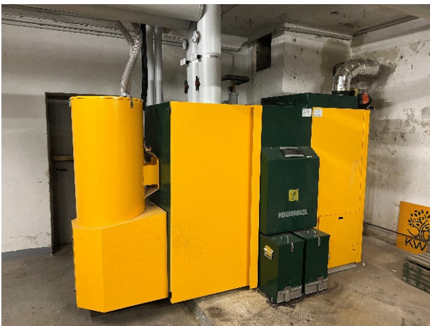
Abbildung 11: Pelletkessel 135 KW
