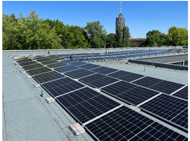
Abbildung 24: Dachaufsicht des Gymnasium bei St. Anna - 2
