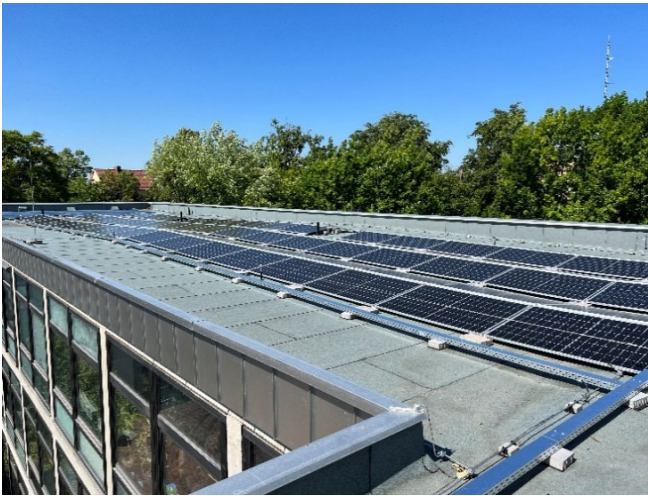
Abbildung 23: Dachaufsicht des Gymnasium bei St. Anna 7
