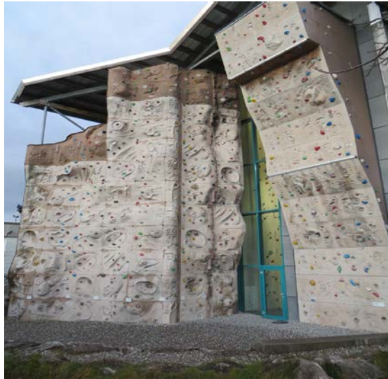
Abb. 8: Kletteranlage des DAV, Sektion Augsburg
